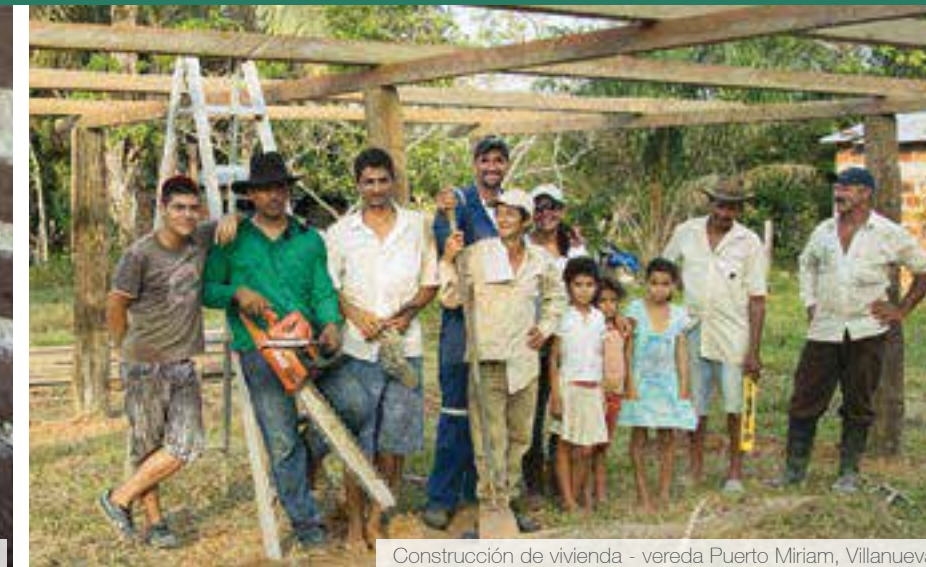
Construcción de vivienda - vereda Puerto Miriam, Villanueva
